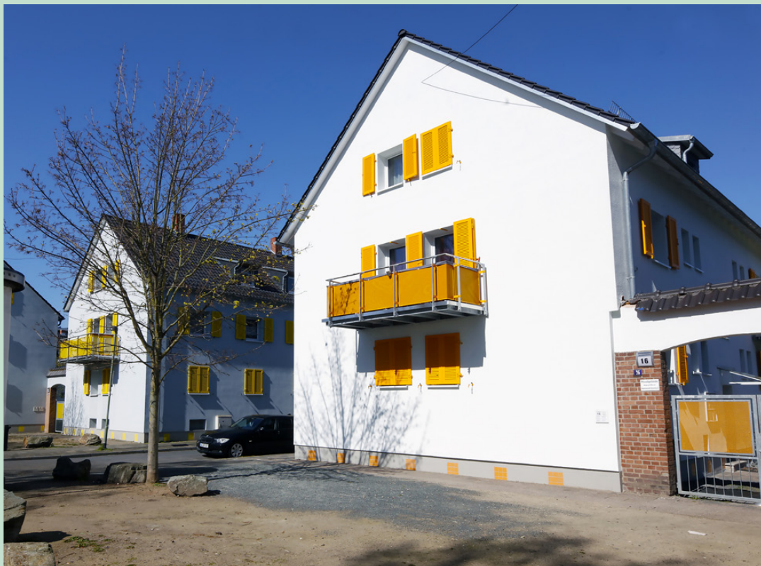
Bild unten: Energetische Modernisierung in der Herzogstraße 16
