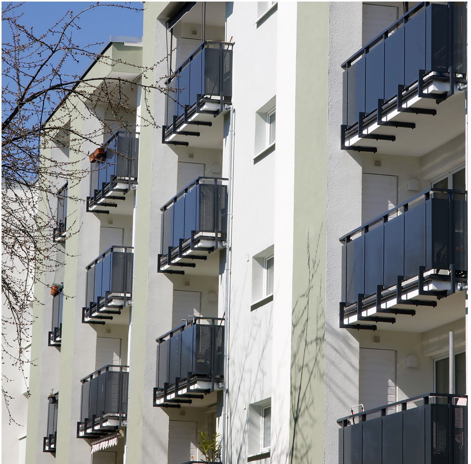
Bild oben: Energetische Modernisierung in der Richard-Wagner-Straße 53/55
