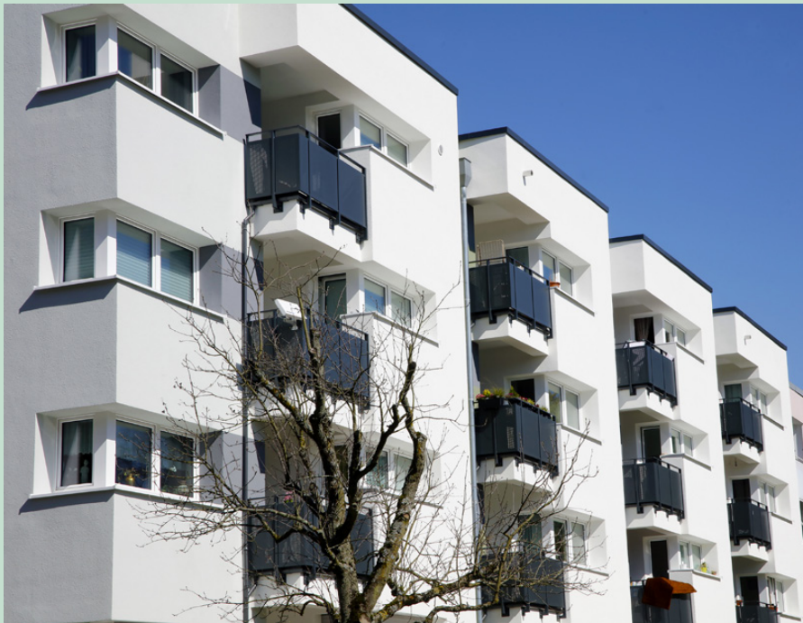
Bild links: Energetische Modernisierung in der Hugo-Wolf-Straße 22/24
