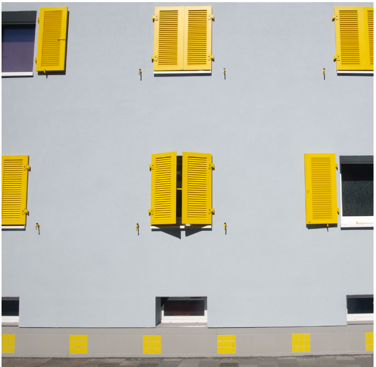
Bild oben: energetische Sanierung in der Blücherstraße 50
